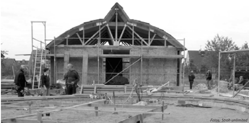
Der Rohbau des Strohballenhauses in Holzständerbau steht in Prenzlau und wurde von Friederike Fuchs entworfen.
