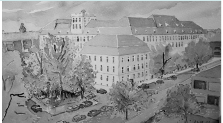
Auch das Haus Beuth auf dem TFH-Campus hat der Maler festgehalten – hier noch vor der gerade laufenden Dachsanierung
