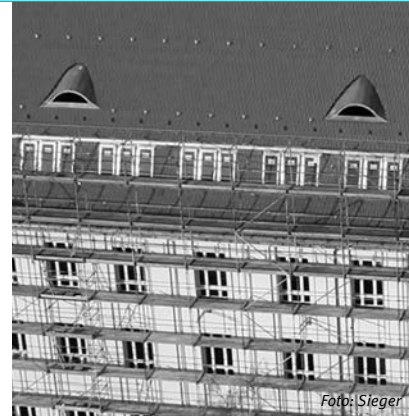
Die Dachsanierung am Haus Beuth hat 10 Monate gedauert und wird im Februar abgeschlossen sein
