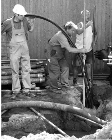
Einbringung der Doppel-U-Rohrsonde in die 100 m tiefe Bohrung mit Messrohr und Verpressrohr
